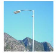
Nella Zona industriale e sulla strada statale, abbiamo installato un prodotto affidabile a LED della marca Philips in grado di dare un alto flusso luminoso in rapporto alla potenza assorbita. In molti di questi pali abbiamo aggiunto delle prese elettriche a servizio delle luminarie natalizie in grado di mantenere il grado di protezione IP66 a spina inserita.
